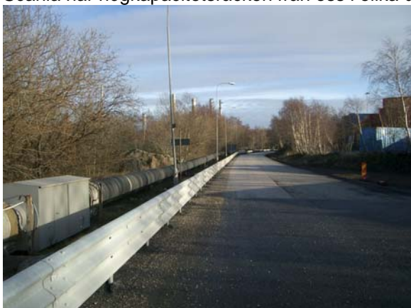
Räcke i kapacitetsklass H2 skyddar en oljeledning ovan mark.
