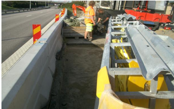
Innan krockdämparen fick sin slutgiltiga position fick kranbilen flytta närmare.
