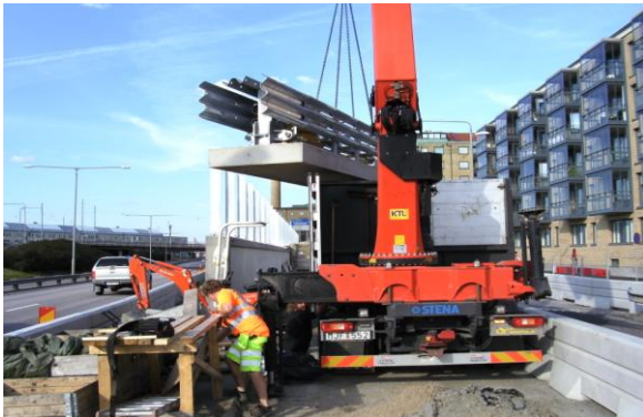
En extremt trång arbetsplats på Fiskehamnsmotet
