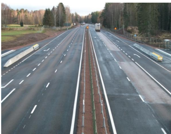
Väg 49 har mellan Axvall och Skara fått ett ordentligt lyft.
