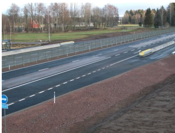
Vägmitt har försetts med ett högt stängsel för att förhindra spring över vägen.
